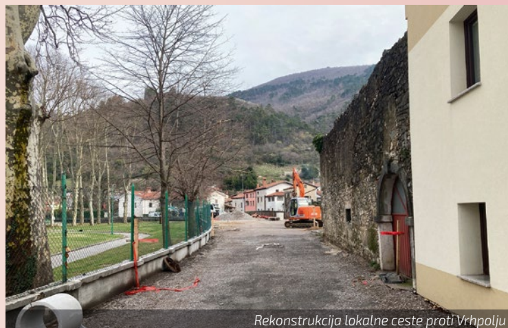
Rekonstrukcija lokalne ceste proti Vrhpolju
